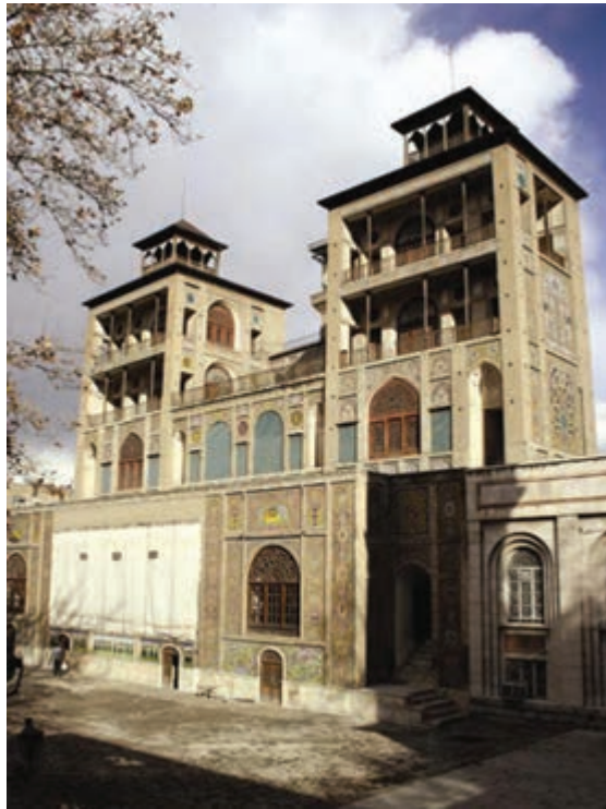
▲ شکل ۹-۱۳- شمس‌العماره، عمارت قاجاری، تهران
